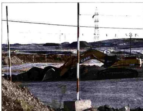
Obras de urbanización en los terrenos de El Cañaveral.
